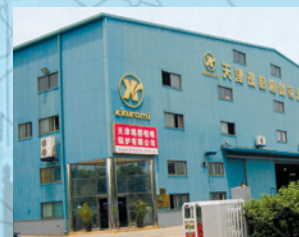
Завод в Кмтае, Тяньцзинь (15315 м 2 )
